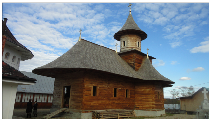
Mănăstirea Zosin – Biserica din lemn, cu hramul „Adormirea Maicii Domnului”, vechiul monument istoric, aflat în prezent în restaurare generală prin reconstrucție capitală.
